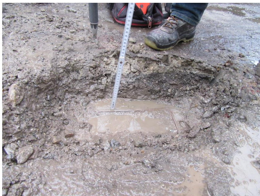
Foto 12 – Widok sięgacza – istniejący wpust – niedrożny
