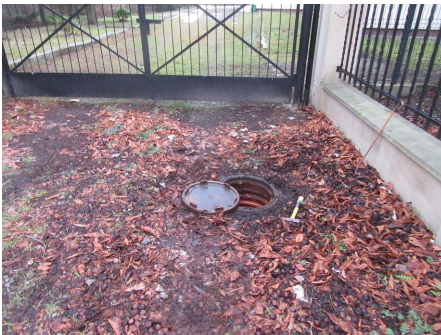
Foto 13 – Widok sięgacza – istniejąca studnia rewizyjna kanalizacji deszczowej – drożna do regulacji.
