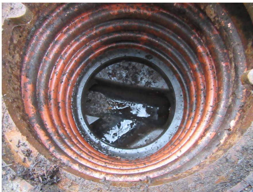
Foto 14 – Widok sięgacza – istniejąca studnia rewizyjna kanalizacji deszczowej – drożna do regulacji.
